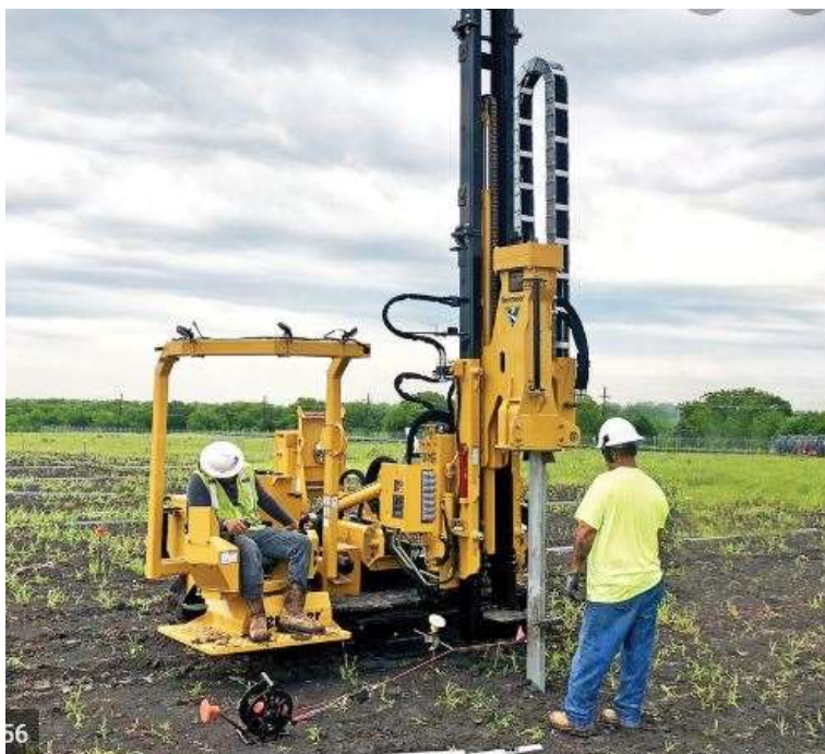
Figur 14. Nedtryckning av stålprofiler i mark.
