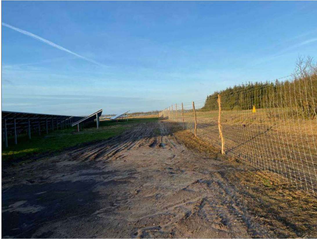
Figur 10. Exempel på utformning av stängsel runt en solcellsanläggning för att bl.a. skydda mot intrång. OBS: En glipa på ca 10-20 cm mellan mark och staket kommer att skapas, för att förhindra barriäreffekt för småvilt.
