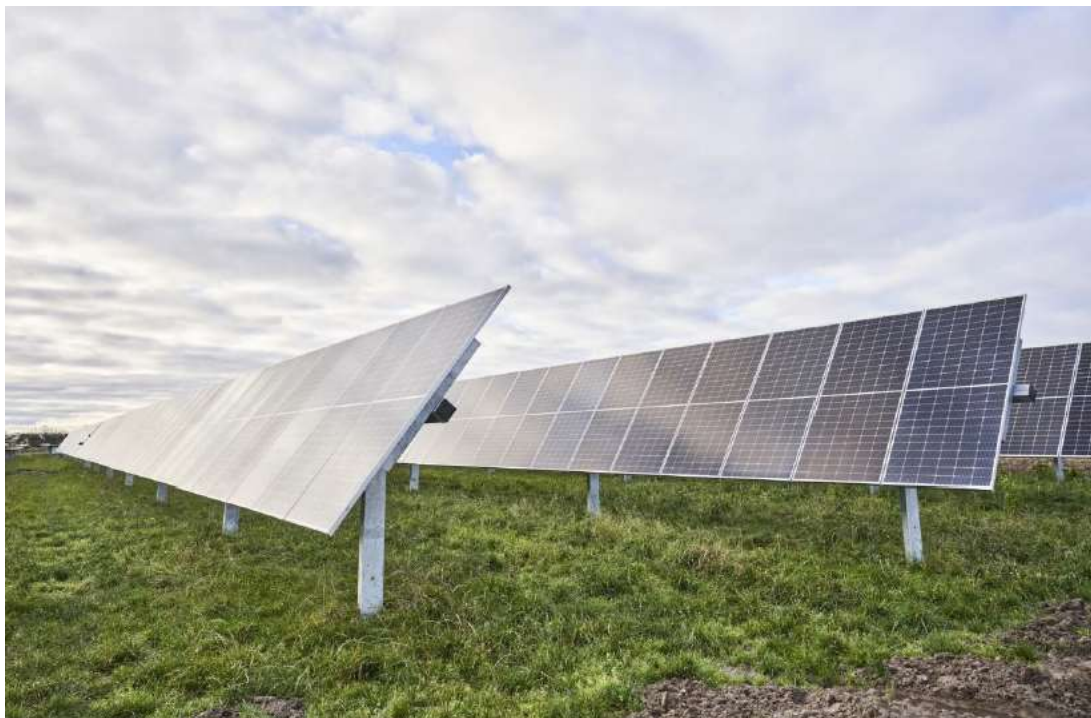
Figur 4. Solcellspaneler placerade på rörliga strukturer, s.k. enaxlade solföljare (Single Axis Trackers, SAT).
