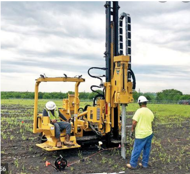
Figur 9. Nedtryckning av stålprofiler i mark.
