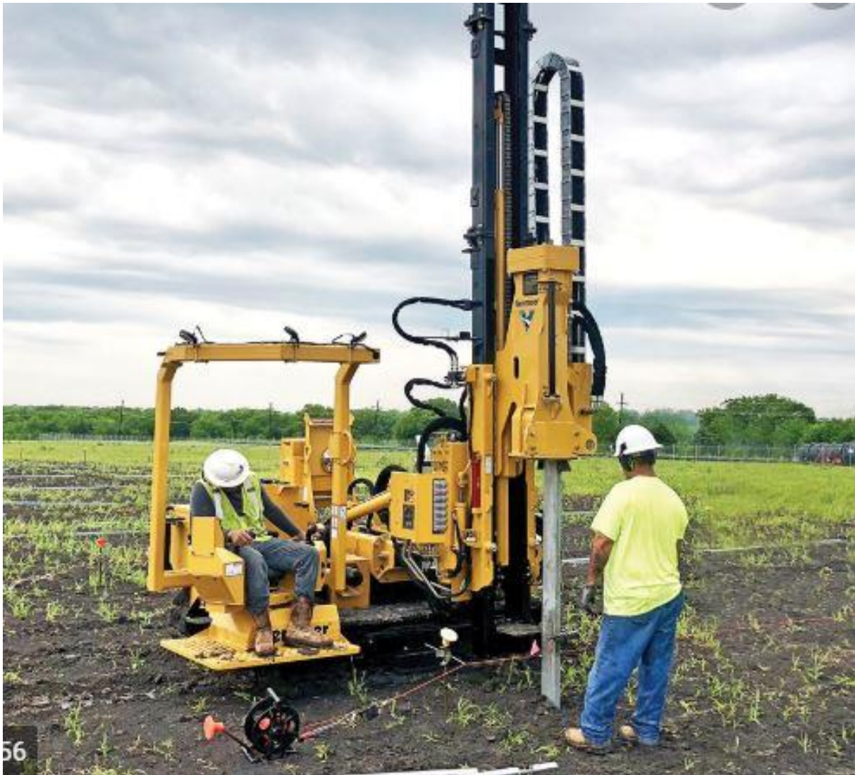
Figur 11. Exempel på nedtryckning av stålprofiler i mark.
