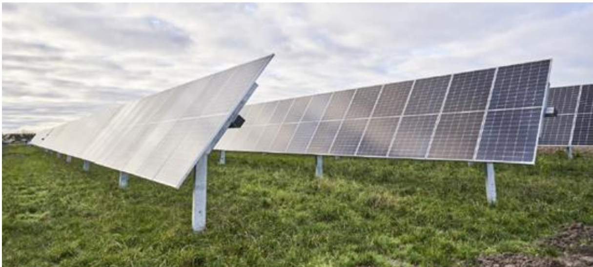
Figur 2. Solpaneler på enaxlad solspårare (Single Axis Trackers).
