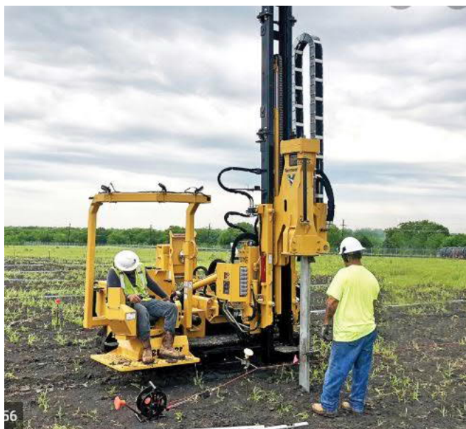
Figur 11. Nedtryckning av stålprofiler i mark.
