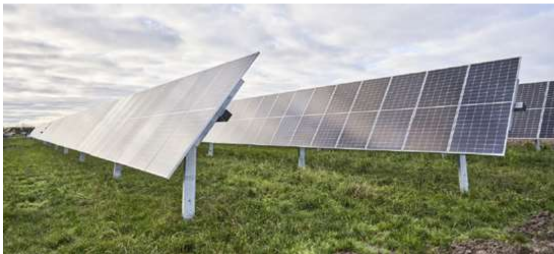
Figur 2 Solpaneler på enaxlad solspårare (Single Axis Trackers).
