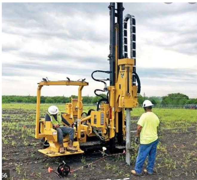
Figur 9 Nedtryckning av stålprofiler i mark.
