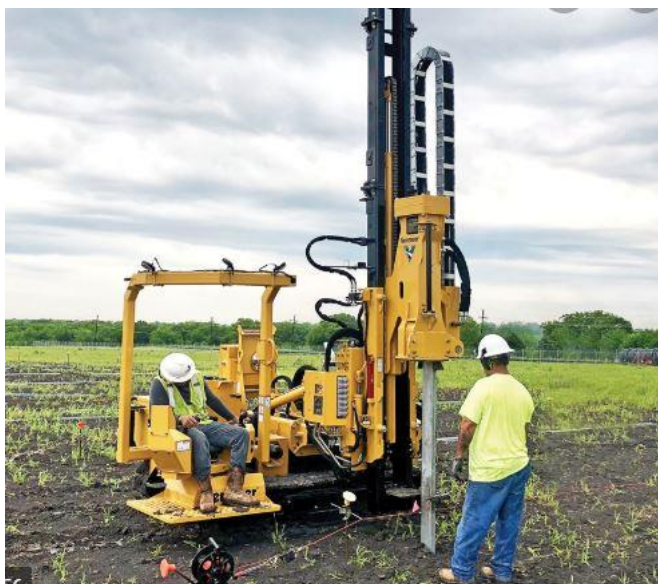
Figur 10. Nedtryckning av stålprofiler i mark.
