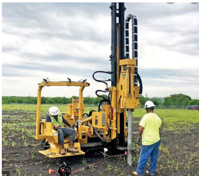
Figur 10. Nedtryckning av stålprofiler i mark.
