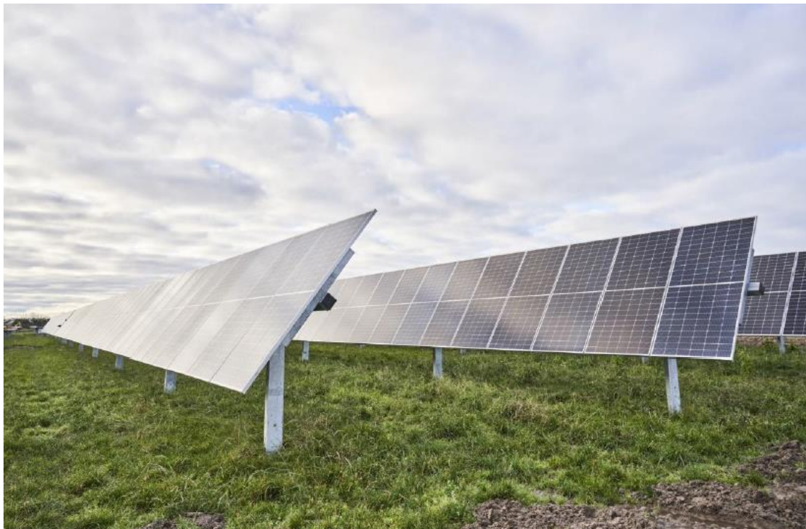
Figur 3. Solcellspaneler monterade på enaxlade solspårare.
