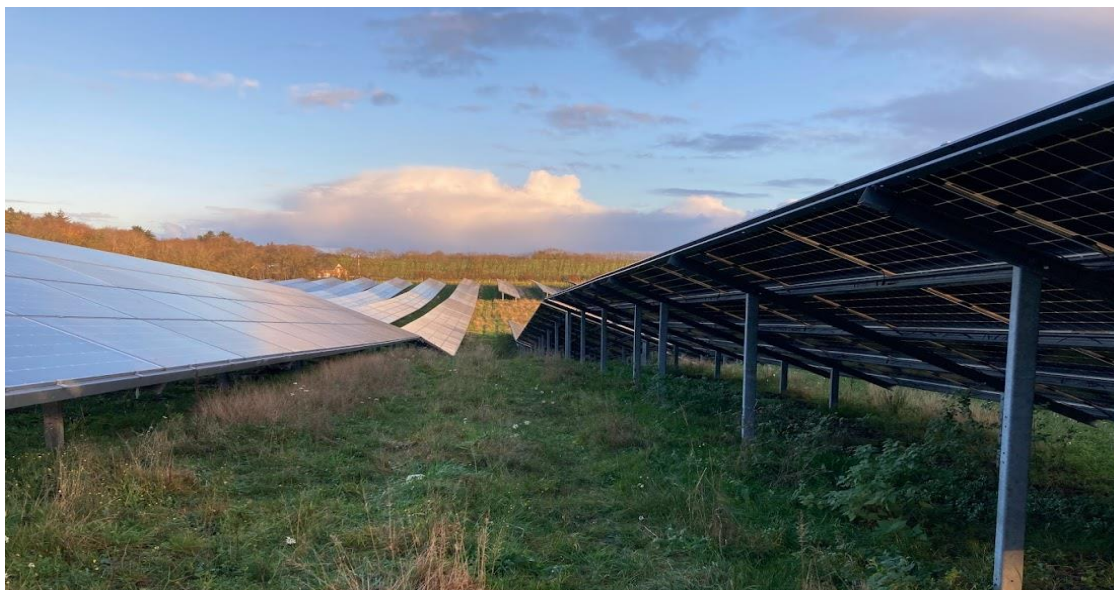
Figur 5. Solcellspaneler monterade på metallstativ.
