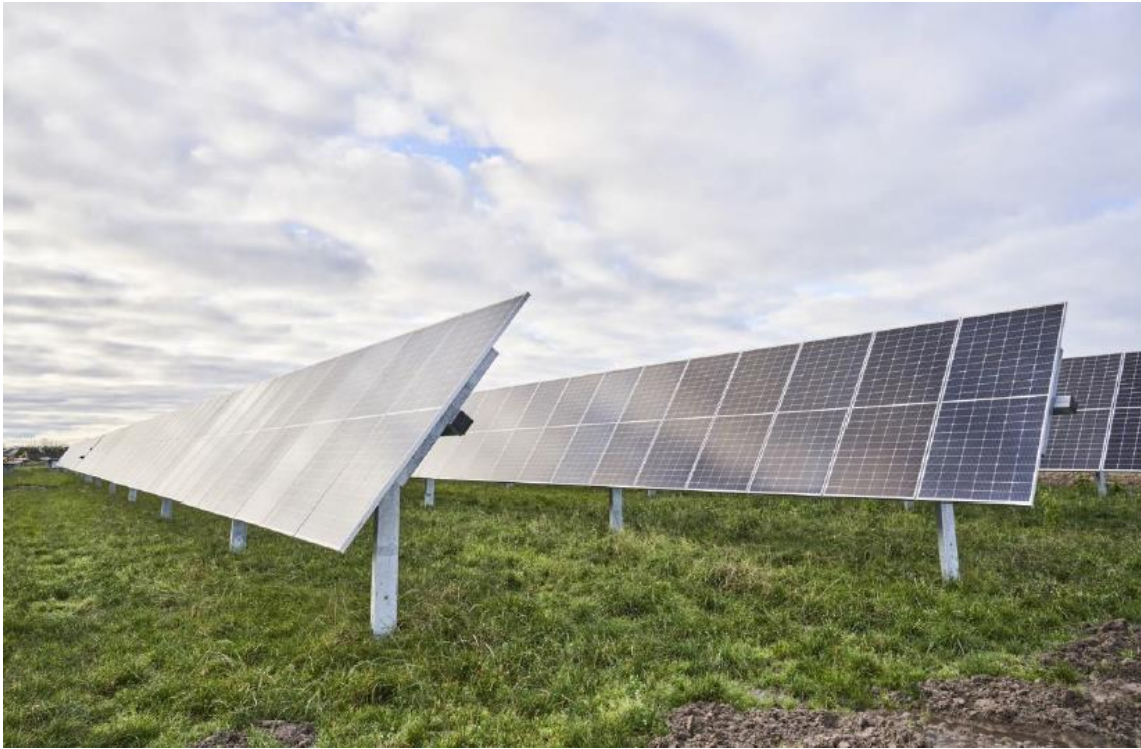
Figur 3. Solcellspaneler monterade på enaxlade solspårare.
