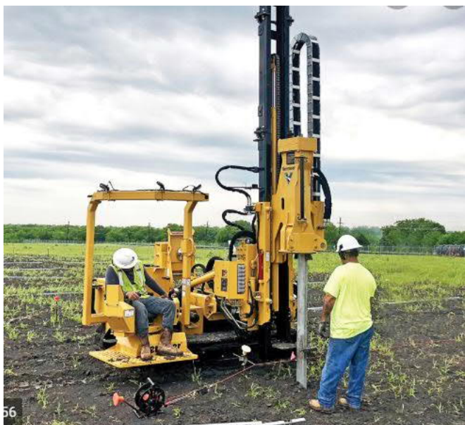
Figur 11. Nedtryckning av stålprofiler i mark.
