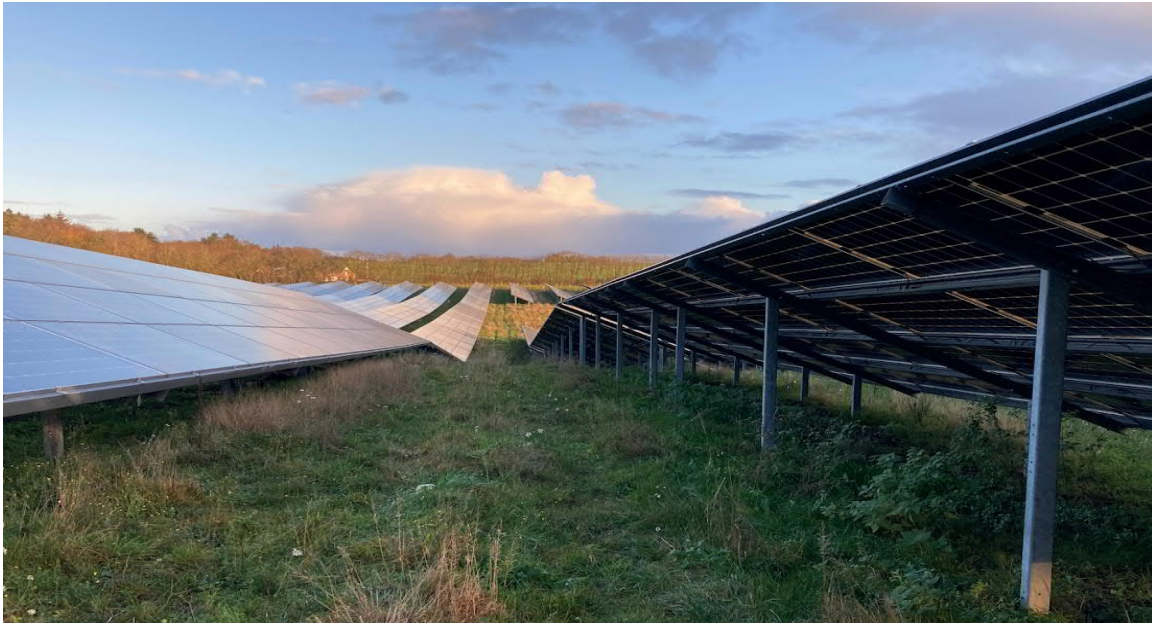
Figur 6. Solcellspaneler monterade på metallstativ. (FT)
