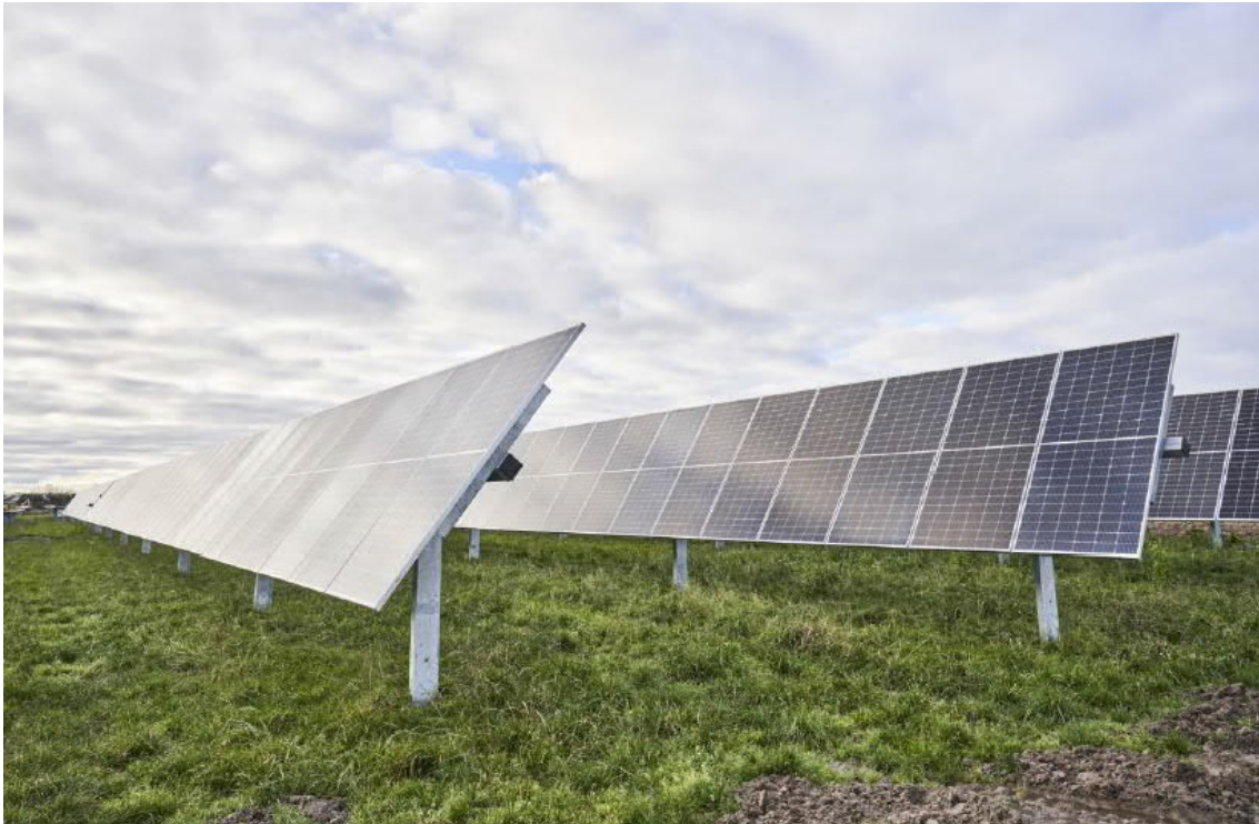
Figur 4. Solcellspaneler monterade på enaxlade solspårare (SAT).
