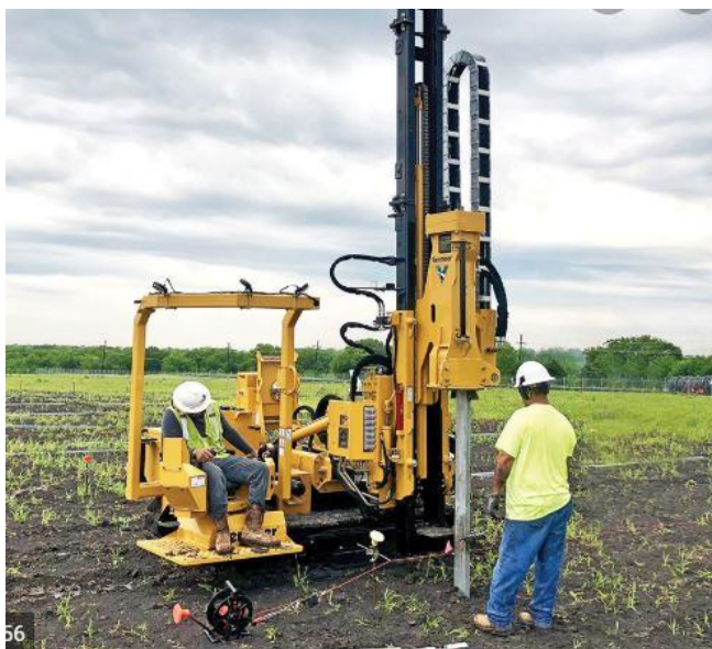
Figur 9. Nedtryckning av stålprofiler i mark.
