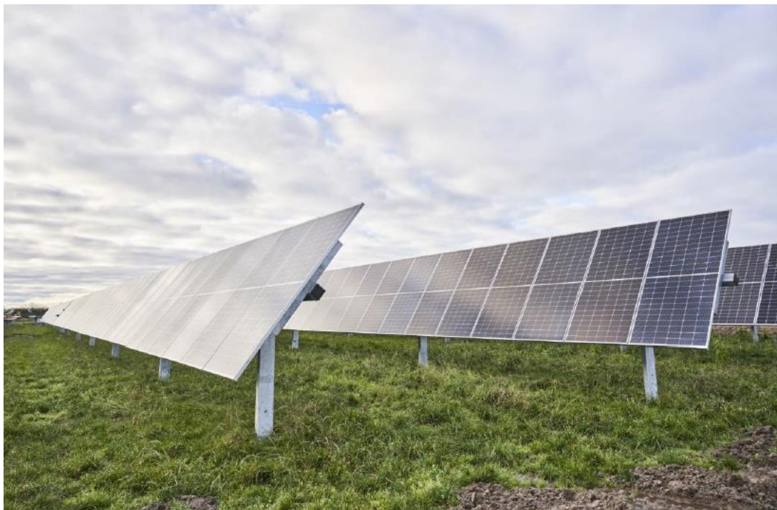
Figur 4. Solpaneler på enaxlad solspårare.
