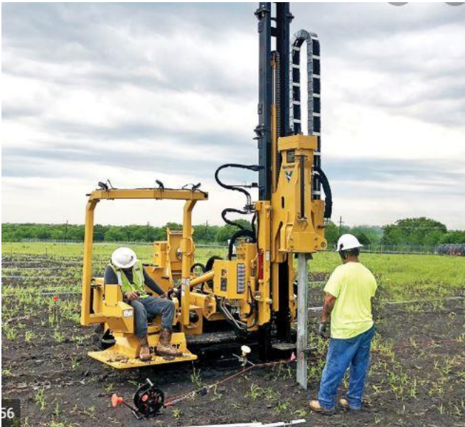
Figur 6. Nedtryckning av stålprofiler i mark.
