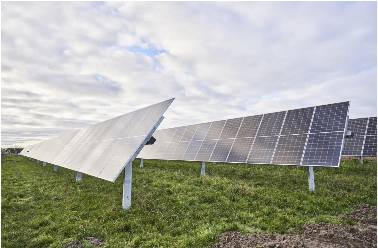
Figur 2. Solpaneler på Single Axis Trackers.
