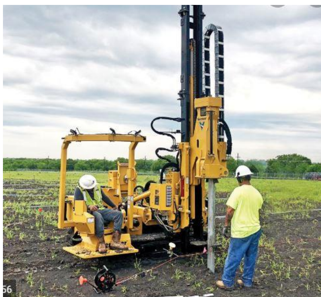
Figur 6. Anläggning av stålprofiler.
